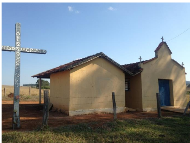
Figura 223 – Capela e centro comunitário Corujas
