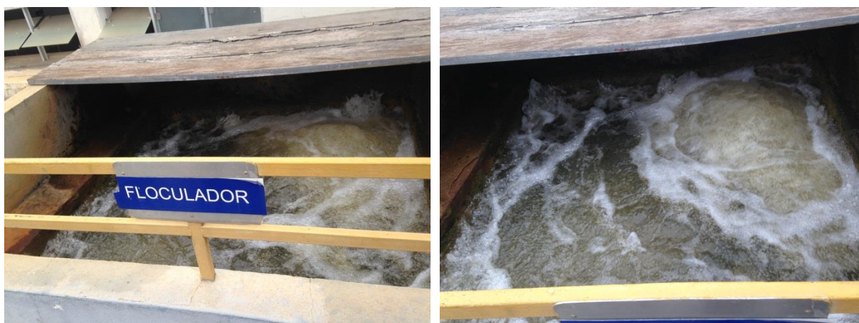
Figura 187 – Floculadores da ETA de Alfenas
