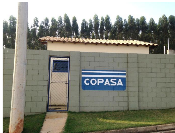
Figura 199 – Vista Área Booster 02
