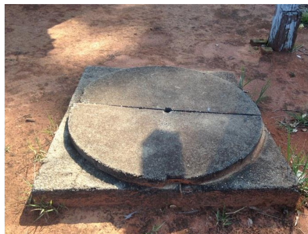
Figura 224 – Cisterna do Centro Comunitário Corujas
