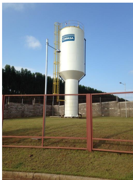
Figura 213 – Vista do Reservatório Elevado 07
