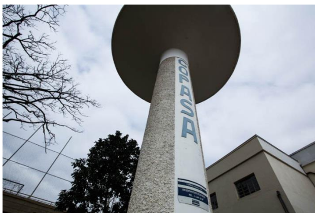
Figura 200 - Reservatório Elevado – REL – 1 CAP
