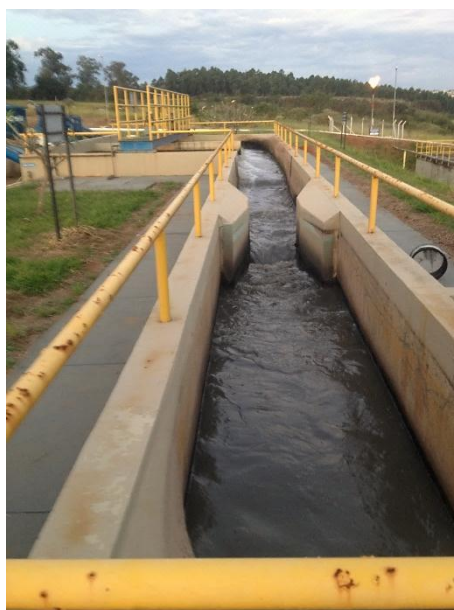
Figura 249 – Calha Parshall
