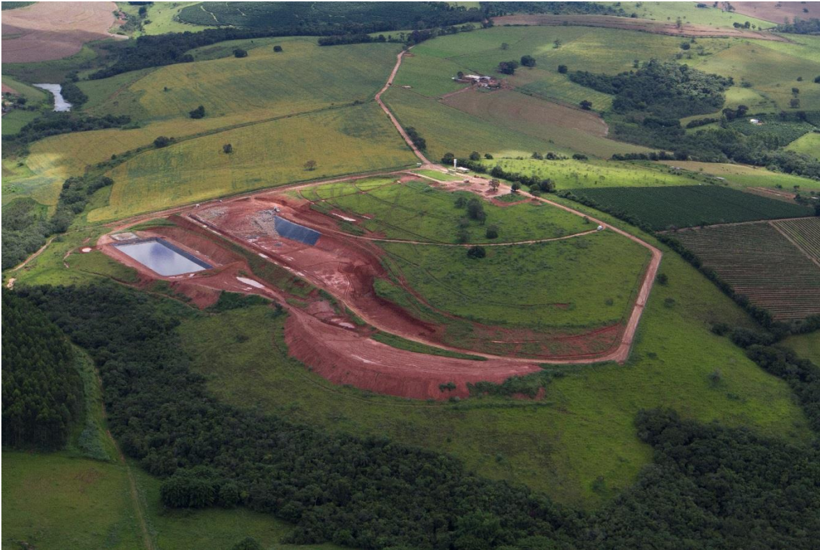
Figura 303 - Vista aérea do Aterro Sanitário – Primeira Vala ativa
