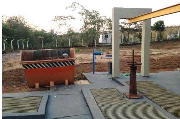
Figura 238 – Tratamento Preliminar EEE 03
