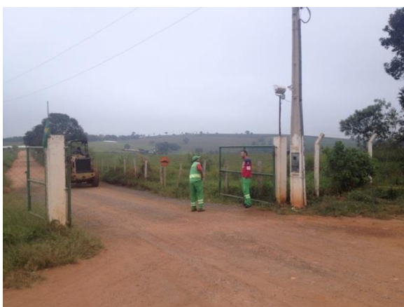
Figura 295 – Portão de acesso ao aterro sanitário
