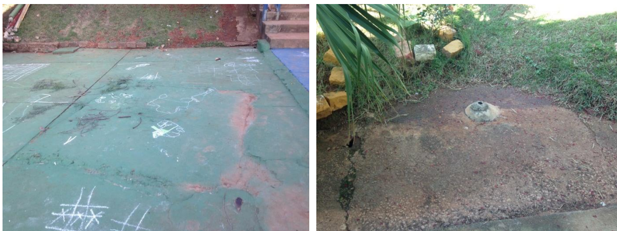
Figura 254 – Fossas Escola Abrão Adolpho Angel
