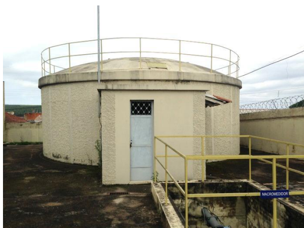
Figura 207 - Vista da RAP 01
