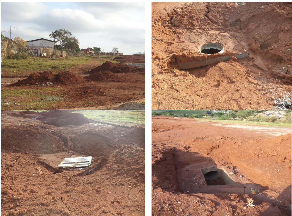
Figura 340 - Novo Loteamento com manilhas para a drenagem local
