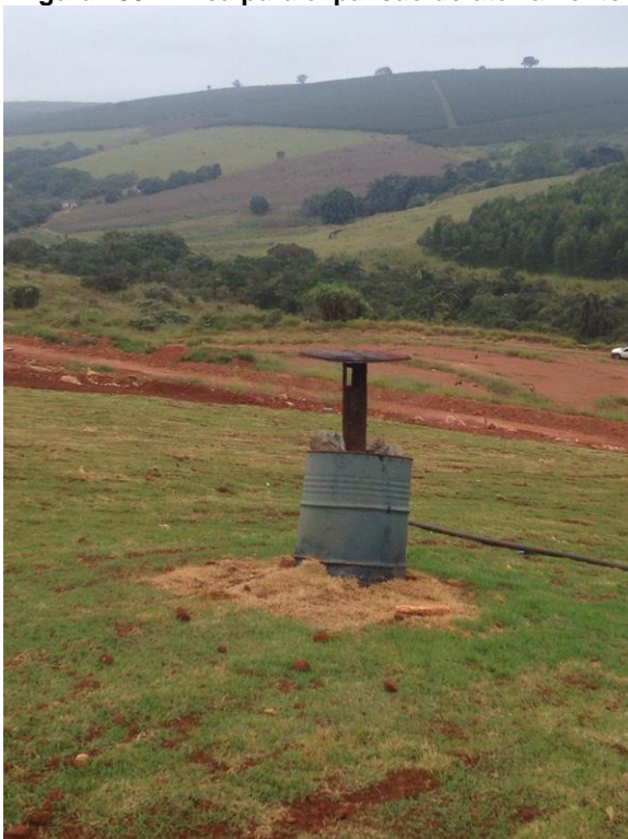
Figura 301 – Coletor e queimador de chorume
