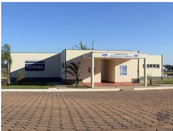
Figura 245 – Vista entrada da ETE de Alfenas
