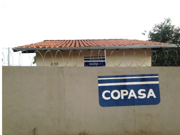
Figura 198 – Vista Área Booster 01
