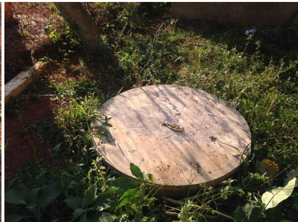
Figura 219 – Segunda Cisterna da Escola Municipal Arlindo Silveira
