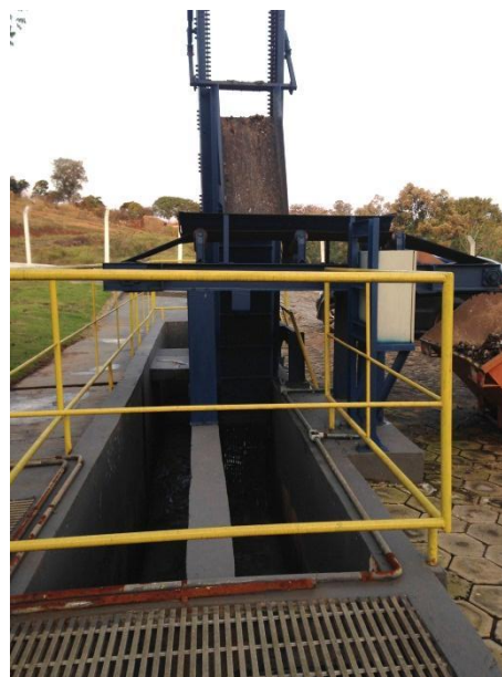
Figura 236 – Tratamento Preliminar EEE 02
