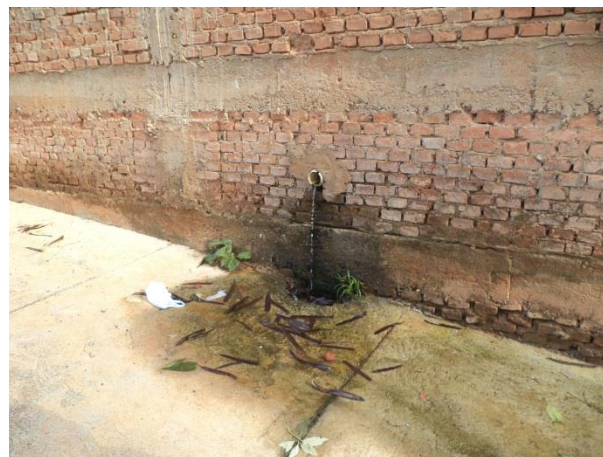
Figura 328 - Rebaixamento de lençol freático - Bairro Boa Esperança
