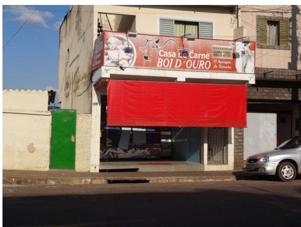
Figura 329 - Construções sob o canal de drenagem (galerias de drenagem) - Av. Lincoln Westin Silveira
