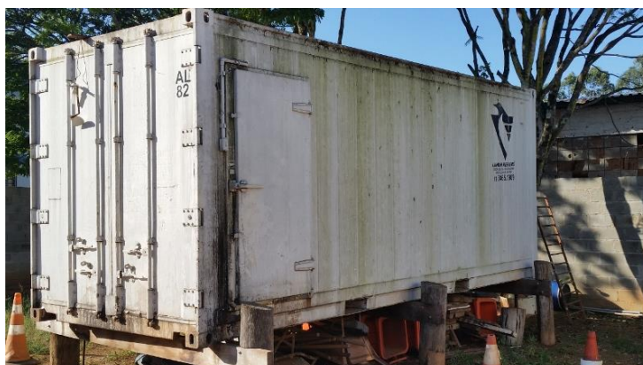
Figura 311 - Câmara Fria para acondicionamento dos resíduos
