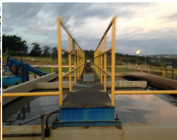
Figura 248 – Vista lateral Desarenadores
