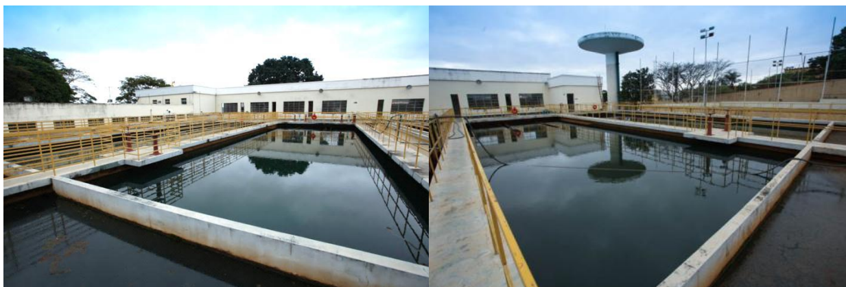
Figura 185 – Vista da ETA
