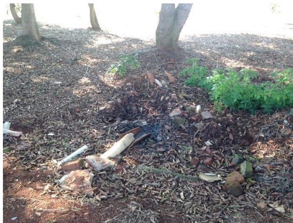
Figura 258 – Lançamento de Efluente Sanitário a Céu Aberto – Barranco Alto
