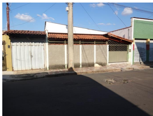
Figura 330 - Construção sob o canal de drenagem (galerias de drenagem) - Rua 13 de maio
