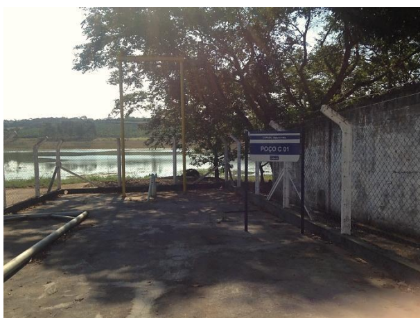
Figura 215 – Vista área Poço Tubular C 01
