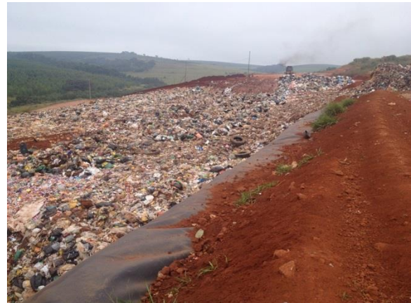
Figura 298 – Atual área de aterramento
