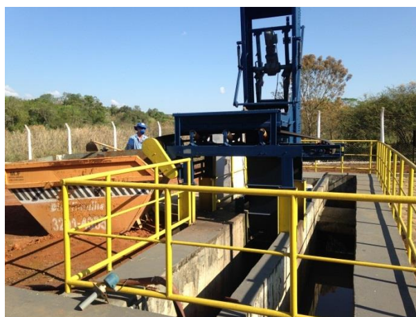
Figura 242 – Tratamento Preliminar EEE 05
