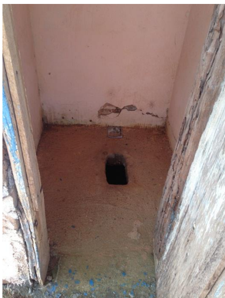
Figura 256 – Sanitário Capela Coruja
