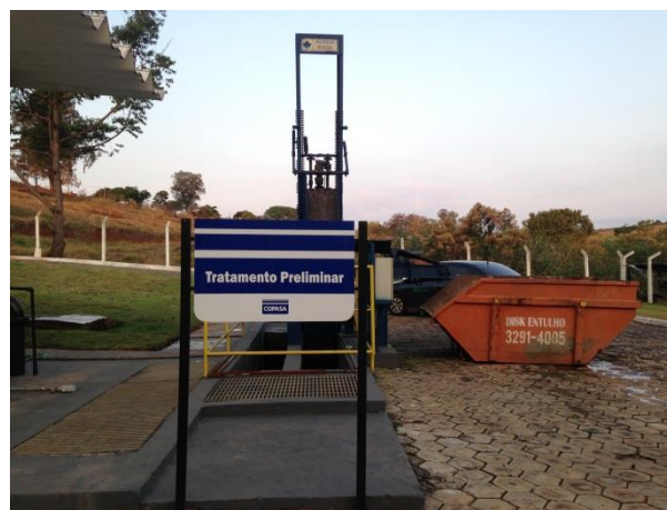
Figura 234 – Tratamento Preliminar EEE 01
