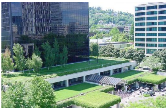
Figura 39 - Controle na fonte: telhados armazenadores
